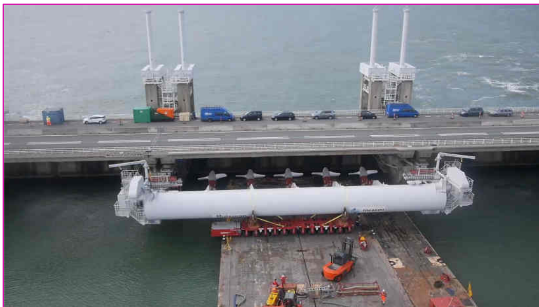
1.25MW dam-geïntegreerde turbines in Oosterschelde Stormvloed Kering
